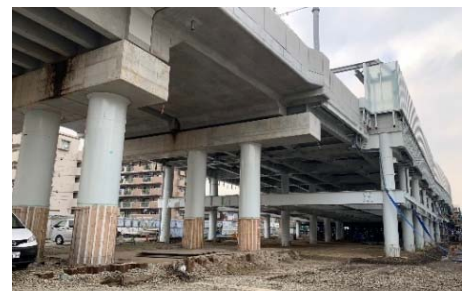
整備中の星川駅高架下
