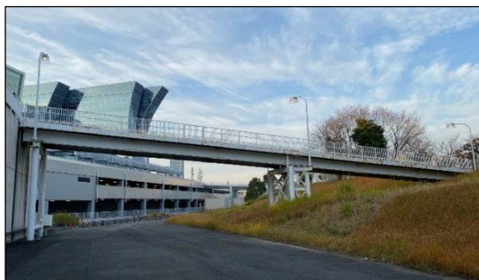
【現在の仮設デッキ】
