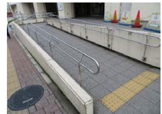
【戸塚センターのスロープ】
