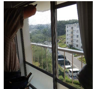
窓ガラス飛散防止フィルム設置作業
