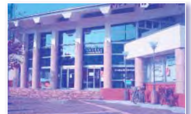
横浜市都筑区福祉保健活動拠点 かけはし都筑
